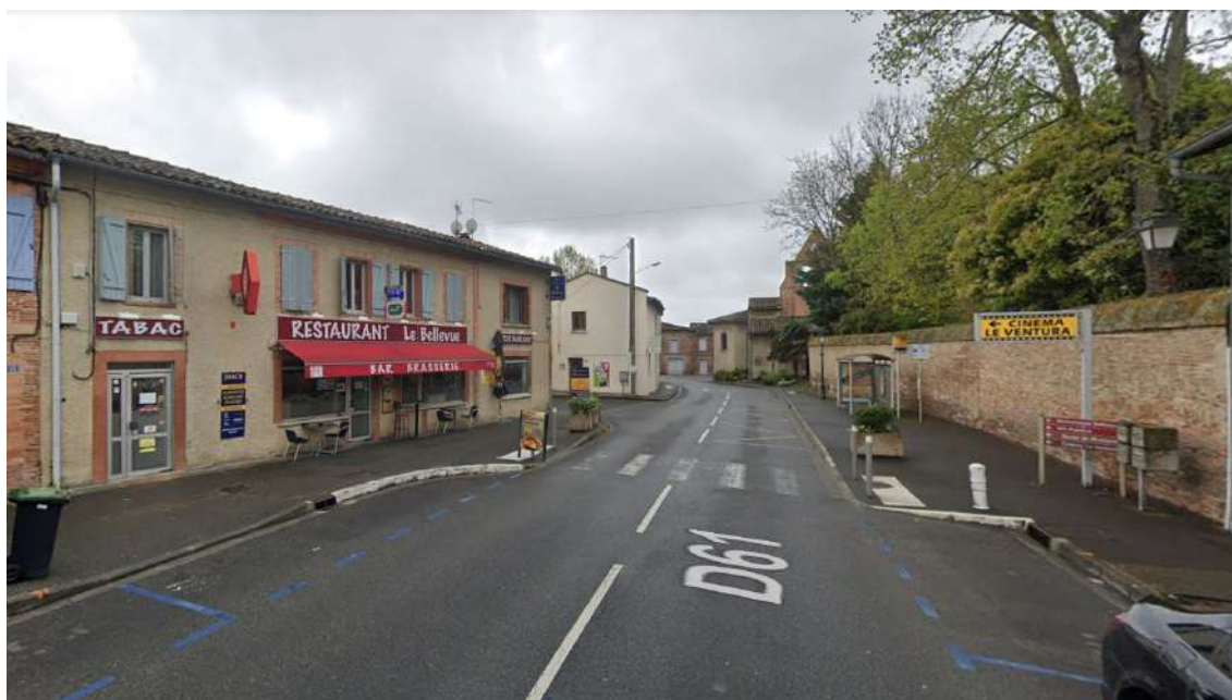
Arrêt de bus Tisseo dans le centre-bourg le long de la RD61
