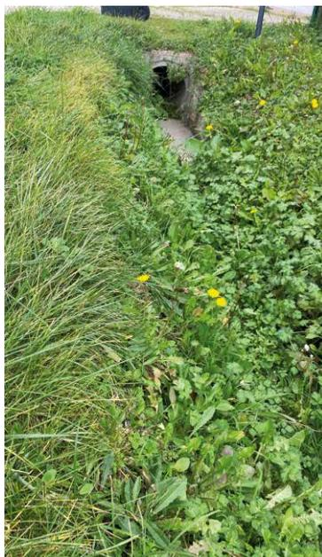
Lorsqu'un **accès busé** dessert une propriété il est nécessaire qu'il soit entretenu régulièrement afin de permettre l'évacuation des eaux. Ainsi tenu en parfait état de fonctionnement cela évite toutes nuisances à l'amont comme à l'aval du fossé. Autrement dit les buses doivent être propres et débarrassées de débris et embâcles qui bloqueraient l'écoulement, en entrée comme en sortie sur 2 mètres.
